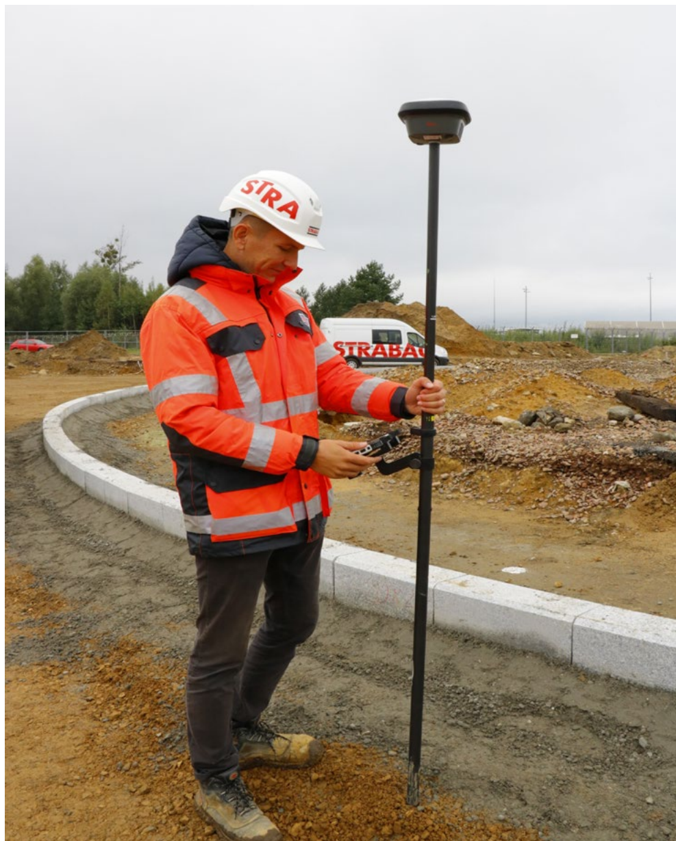
Fot. Prace na budowie, kwiecień 2023 r.
