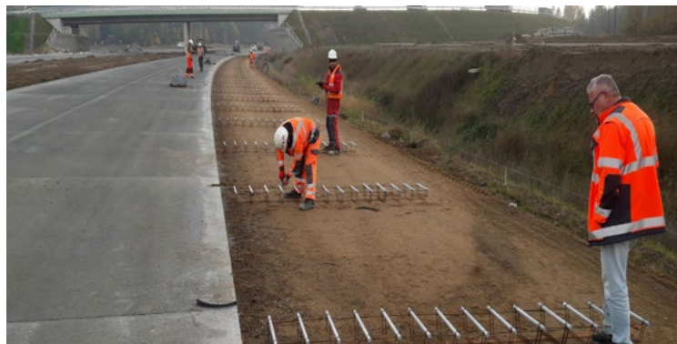
Fot. Michał w trakcie prac przy nawierzchni betonowej
