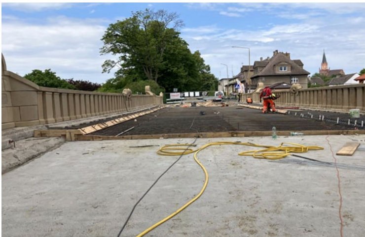
Fot. (góra) Sprzęt TPA do wykonania odwiertów i badań posadowienia obiektu; (środek) Rusztowania podwieszone dla prac konserwatorskich od zew. i spodniej części mostu; (dół) prace przy wykonywaniu nawierzchni mostu
