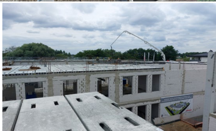
Fot. prace budowlane na obiektach kompleksu szkolnego
