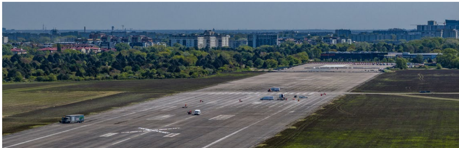
Fot. Droga startowa lotniska Warszawa-Babice
